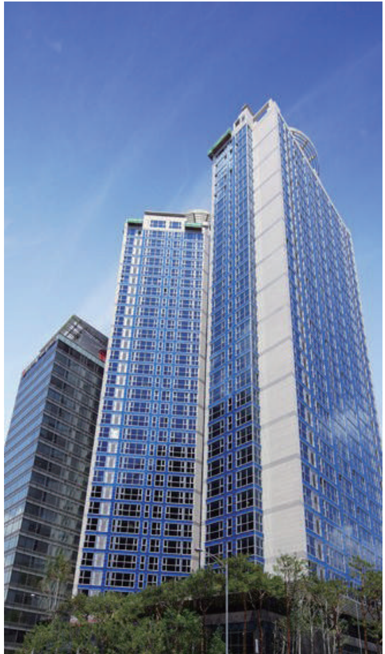
남산 플래티넘 굿디자인(GD)선정(2007년) 설계/ (주)유선엔지니어링건축사사무소 시공/ 쌍용건설(주) 사진자료출처:쌍용건설(주)
