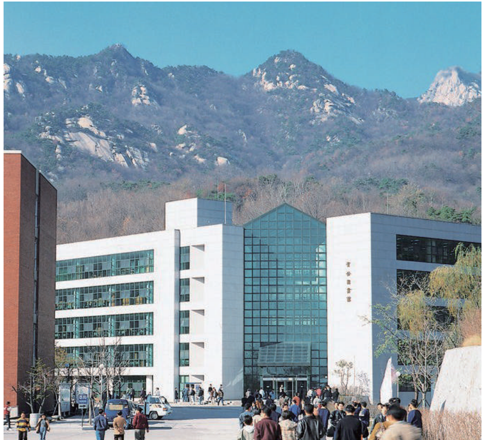
설계/ 서상우 + 박길룡 (국민대 건축학과 교수) 시공/ (주)쌍용건설
